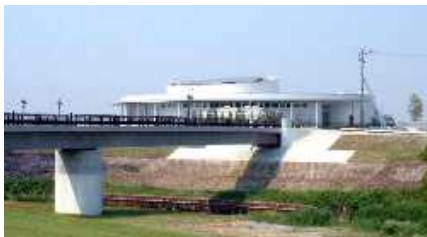
本館(南の方角から見て)
